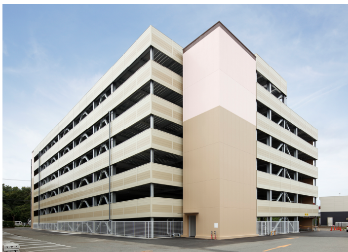
「サントムーン 柿田川」アネックス第2立体駐車場の外観
