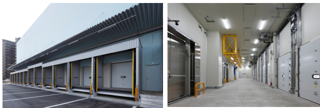
搬入・搬出口の外部と内部
